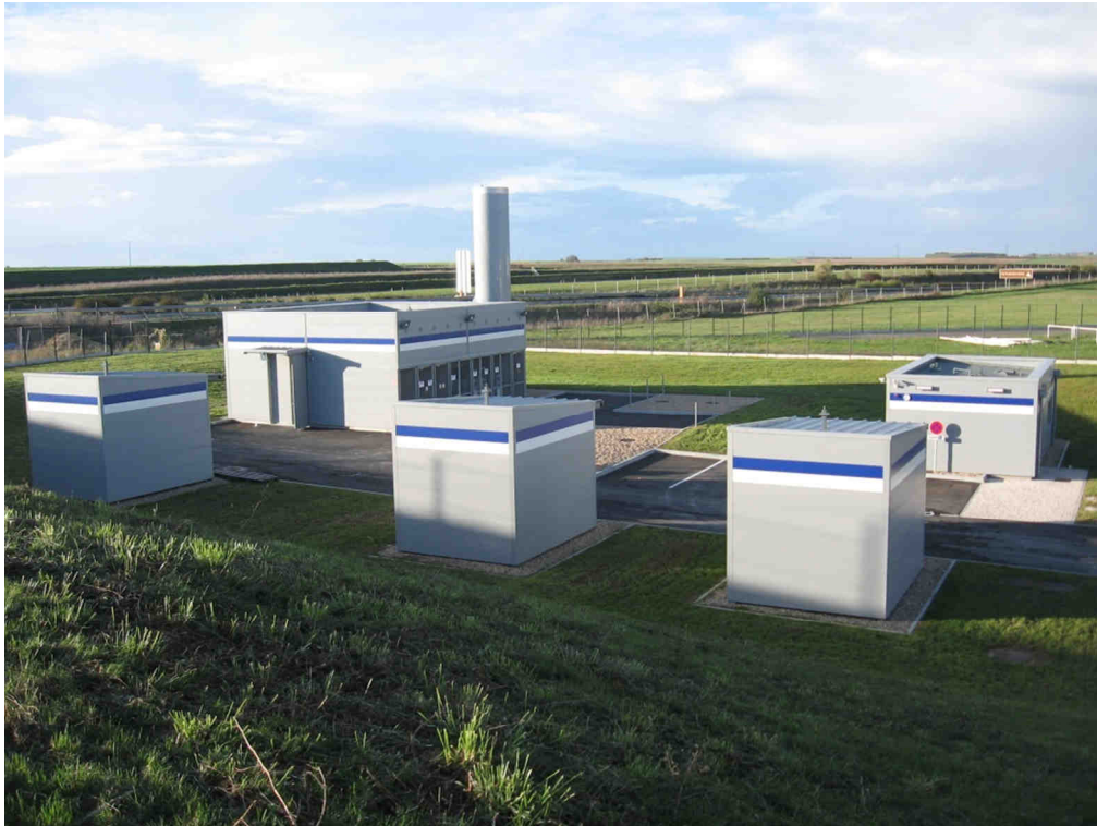
Infrastructure dédiée au projet PERGOLA
